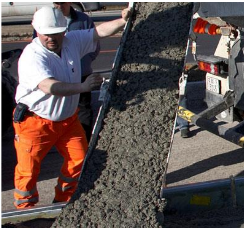
Obrázok 13 Sypanie betónovej zmesi pomocou žľabu
