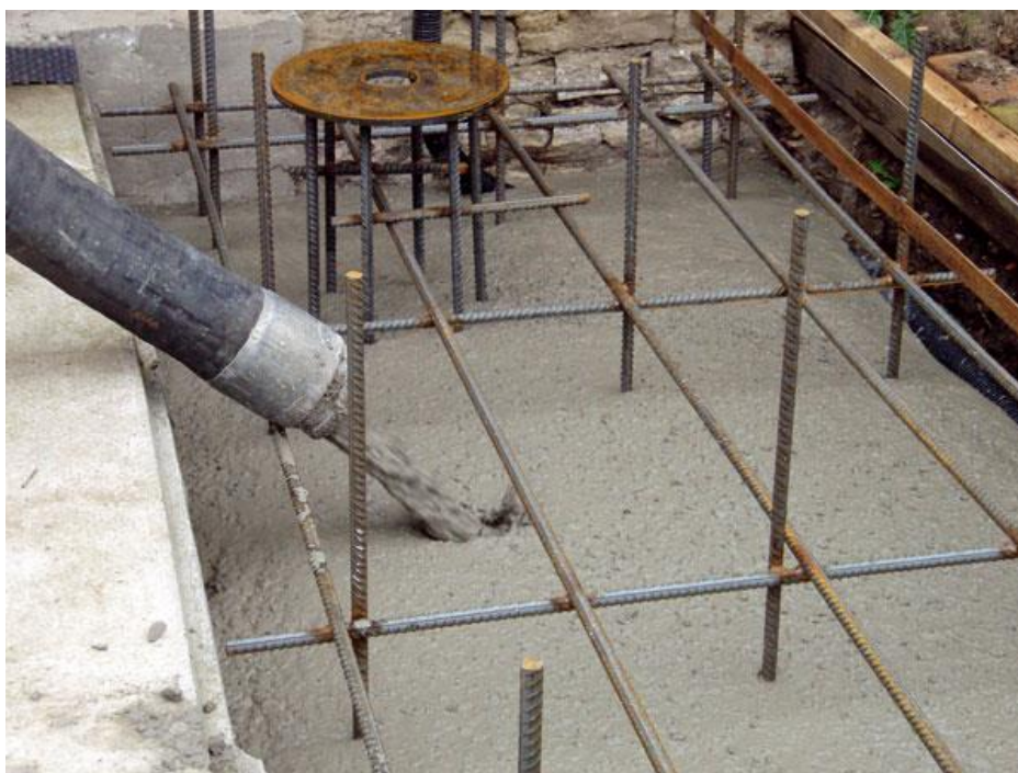
Obrázok 19 Betónovanie konštrukcie, zalievanie výstuže
