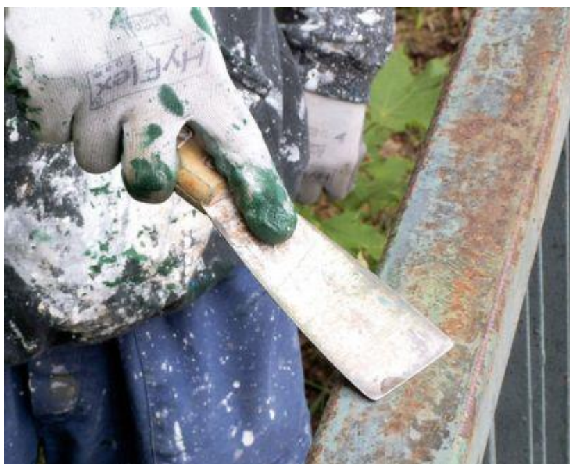
Obrázok 66 Mechanické odstránenie starého náteru
