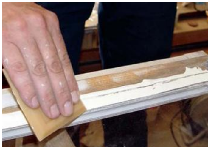
Obrázok 64 Brúsenie starých náterov
