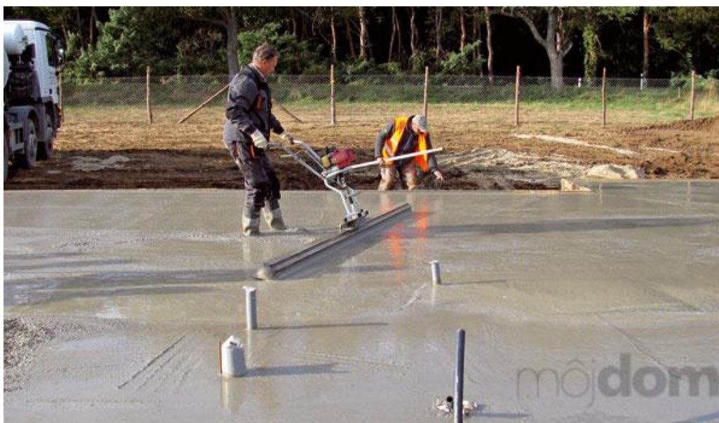
Obrázok 20 Zhutňovanie vibrovaním
