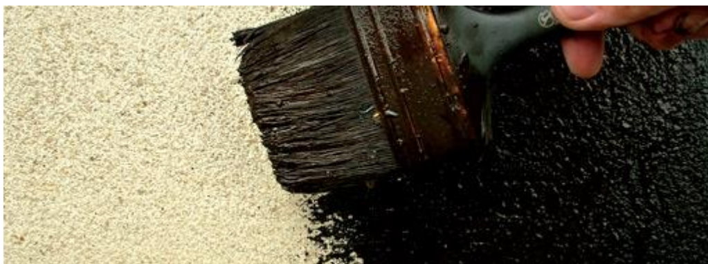
Obrázok 71 Nanášanie penetračného náteru
