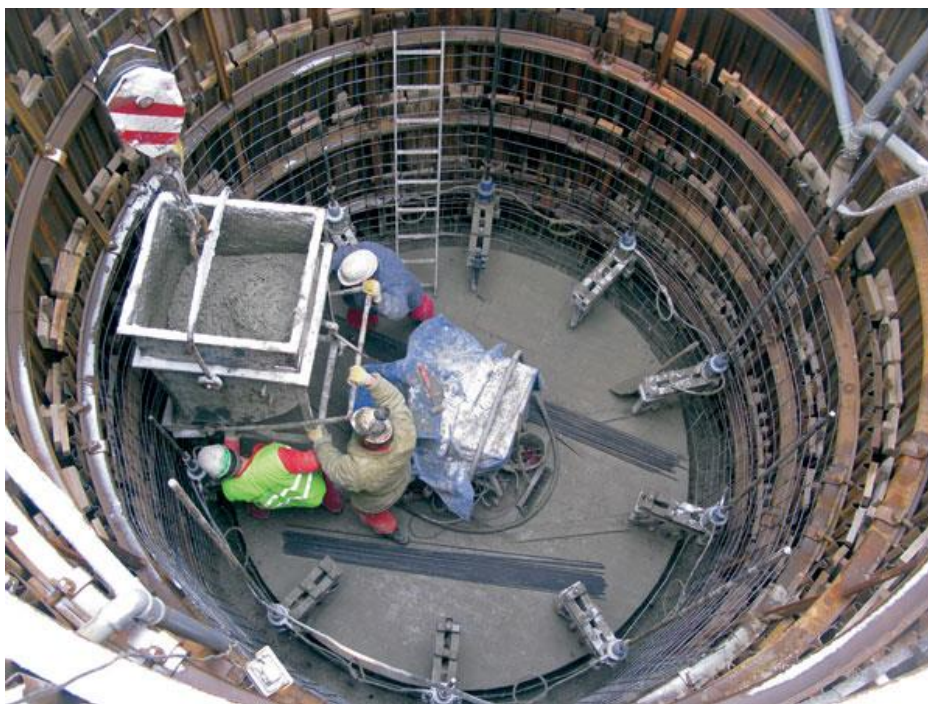
Obrázok 15 Veľkoplošné kruhové debnenie
