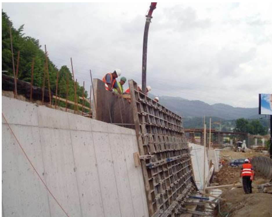
Obrázok 14 Veľkoplošné debnenie
