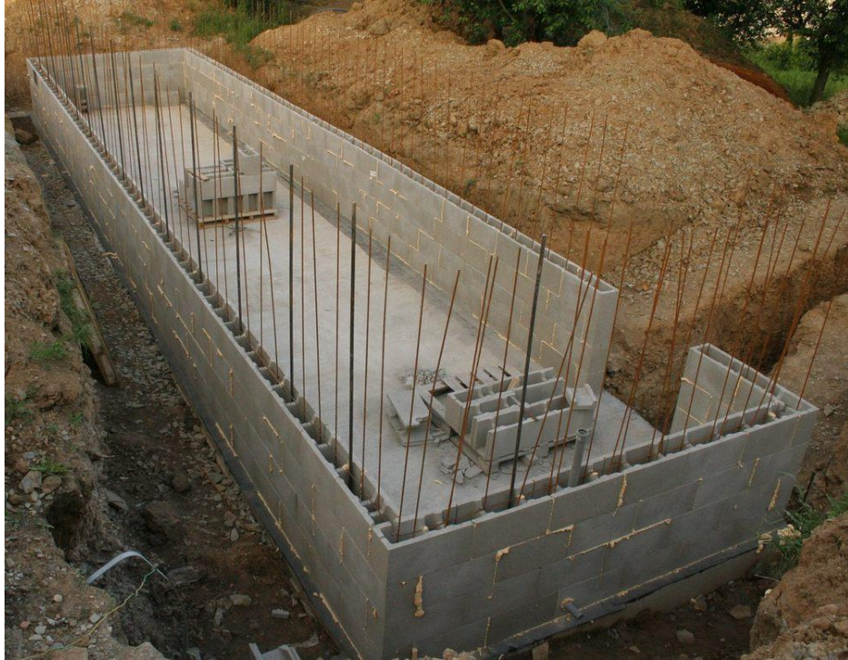
Obrázok 24 Murovanie z betónových tvárnic
