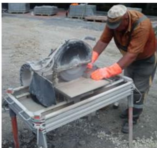
Obrázok. 37 Pílenie kameňa pomocou ručnej mechanizácie
