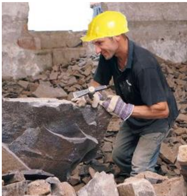
Obrázok 31 Ručné opracovanie kameňa
