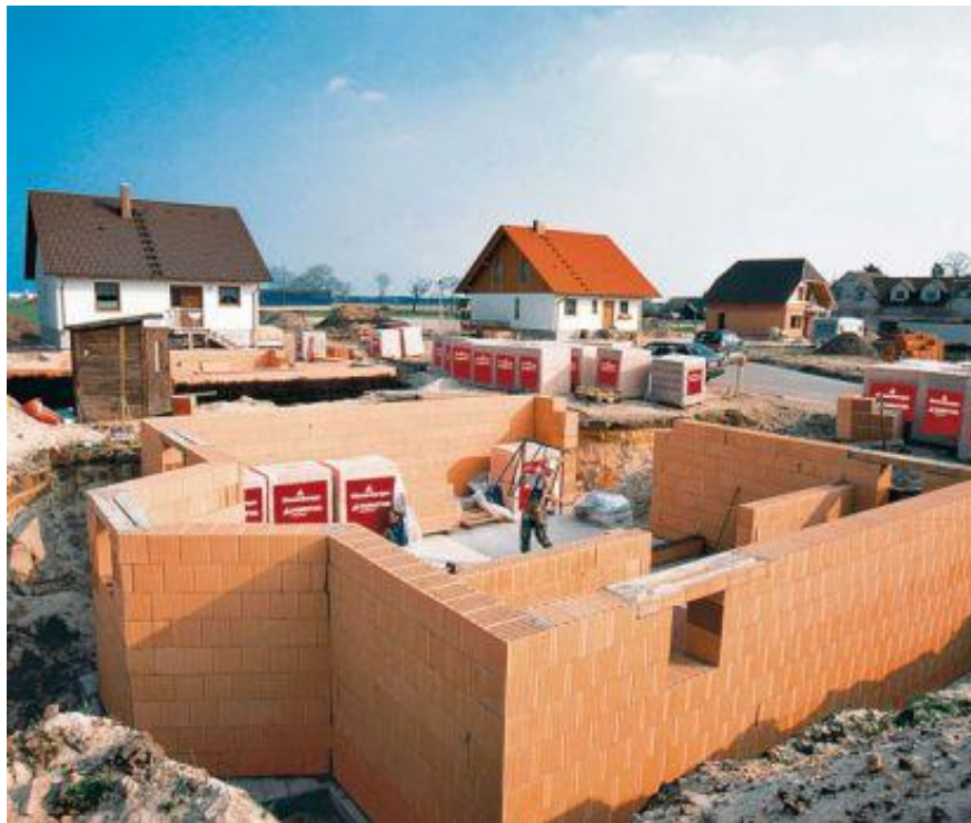
Obrázok 22 Výstavba bytových jednotiek
