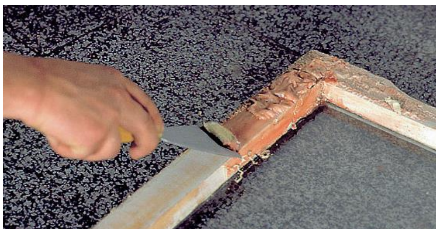
Obrázok 63 Odstraňovanie starých náterov z dreva
